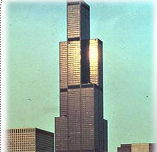
골조튜브 방식의 Shear Lag 현상을 최소화하기 위해 평면 중간 부분에 횡력과 평행한 방향으로 튜브 구조체를 넣어 횡력을 지지하도록 하는 방식
